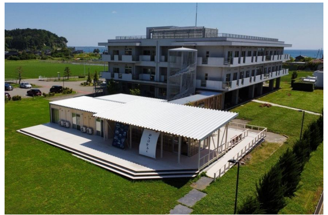
（珠洲市）長寿園ふれあいセンター（3月19日開設）
