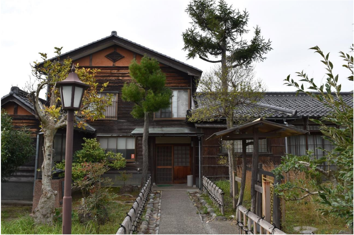
外観（閲覧室・主屋）
