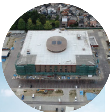
建設中の建物の様子 (R3.9撮影)
