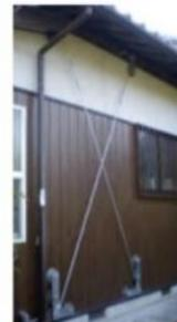
(参考)一般的な工法である「①筋かいで補強」とのコスト比較
