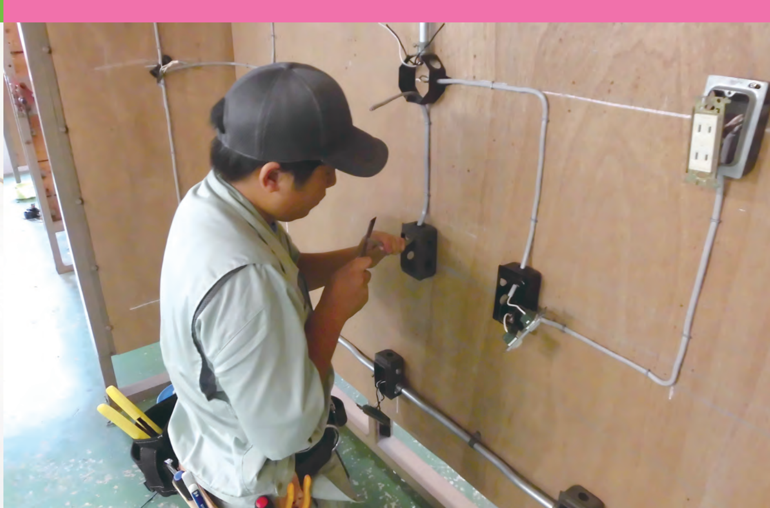
屋内配線実習
