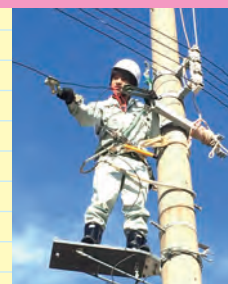
外線工事実習
