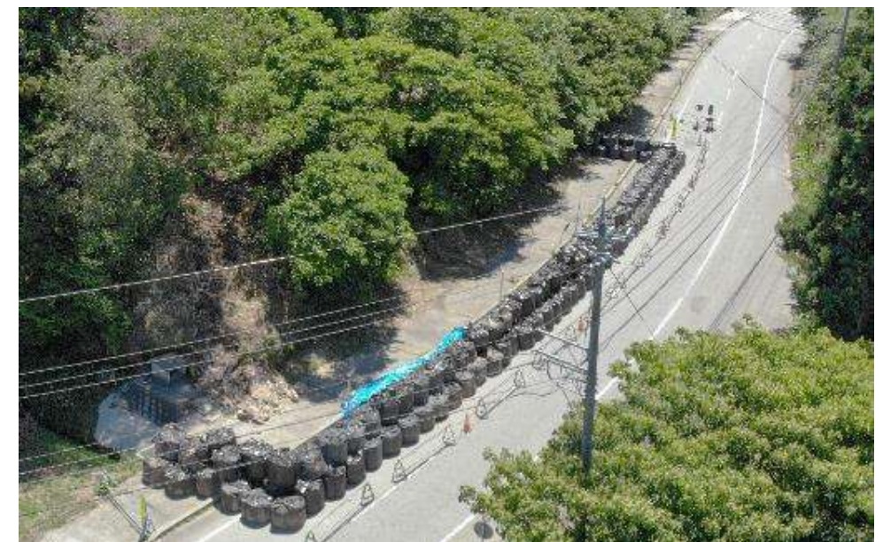
R4 能登地方の地震による道路法面の被災
