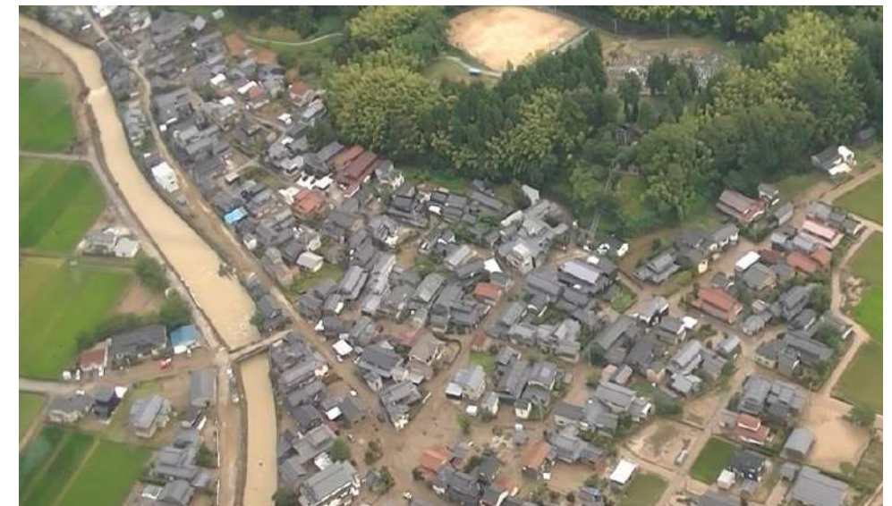
R4.8.4から的大雨による小松市中海町の浸水
