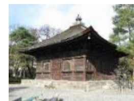
善光寺「経蔵」の耐震 補強工事に採用(H29)
