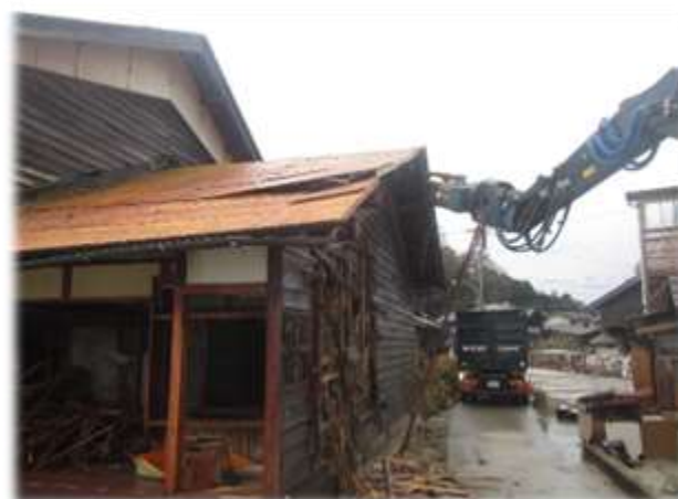
公費解体の様子
