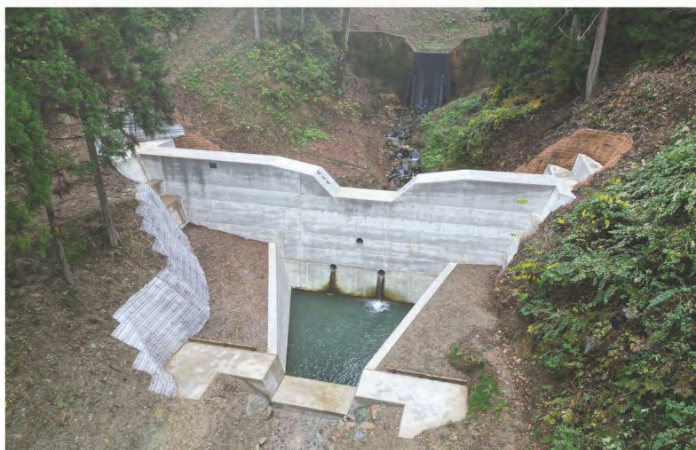
治山工事による山地保全(金沢市熊走町)
