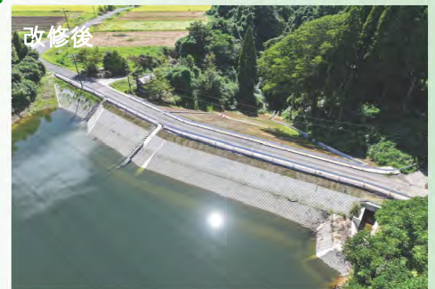
老朽ため池整備事業 新三郎池地区 (河北郡津幡町字笠池ヶ原)
