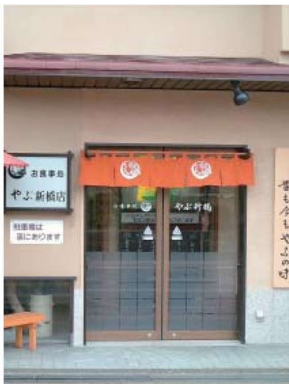
▲ 店舗出入口 (引戸) を自動ドアに改修 (輪島市まんなか商店街：やぶ新橋)
