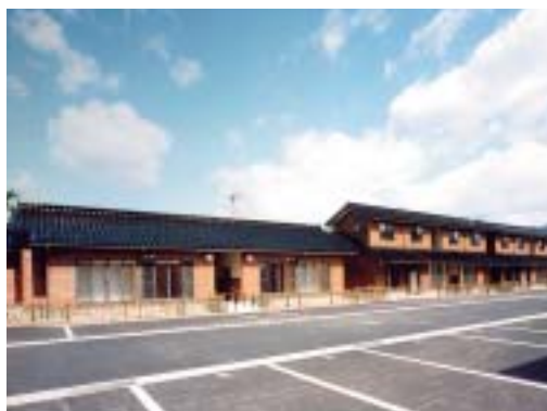
門前町 町営松風台団地
