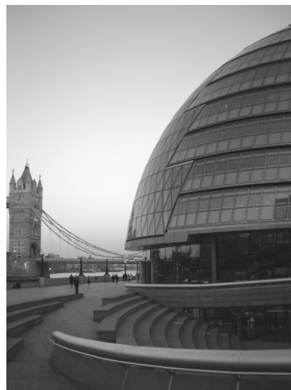
楕円形と螺旋の軌跡によって構成された 建物、階段、傾斜路が洗練されたデザイン として組み合わせられている例である。 （ロンドン・シティ・ホール・イギリス）
