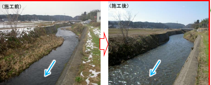
鶺鴒川における河道掘削、樹木伐採 (石川県)
