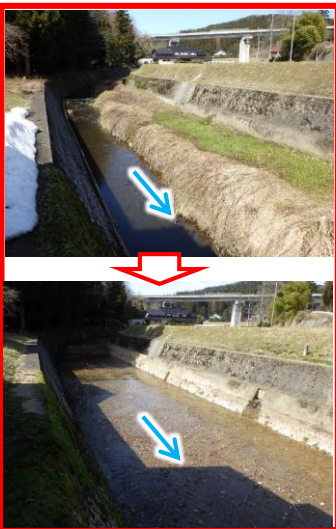
鈴内川における浚渫工事の実施（珠洲市）
