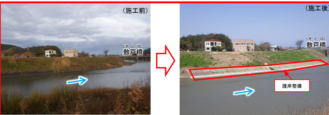
町野川における河川改修の実施（石川県）
