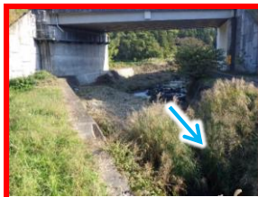
寺分川における浚渫工事の実施（能登町）
