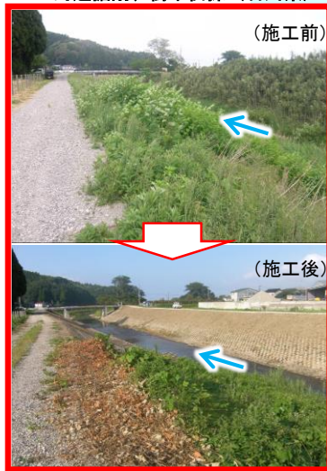
鳳至川における河道掘削、樹木伐採（石川県）
