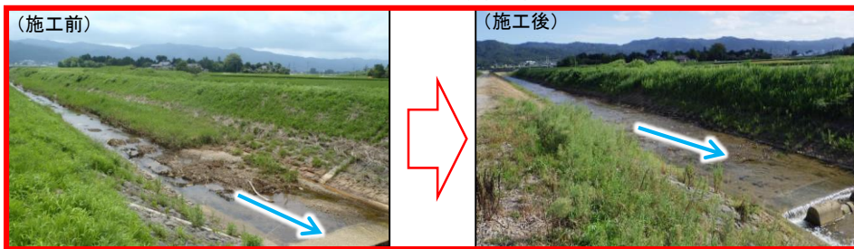
二宮川における河道掘削、樹木伐採（石川県）
