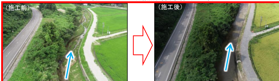
伊久留川における河道掘削、樹木伐採（石川県）
