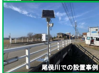
尾俣川での設置事例
