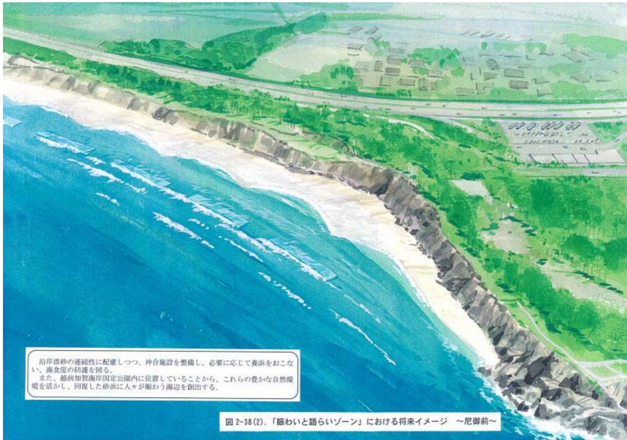
沿岸漂砂の連続性に配慮しつつ、沖合施設を整備し、必要に応じて養浜をおこない、海食崖の防護を図る。
