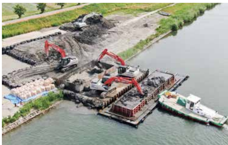
工事現場の様子
