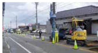
管路液状化対策（梯川処理区）
