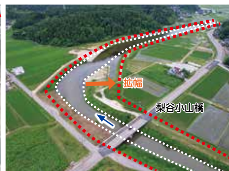
米町川（梨谷小山橋付近の拡幅）
