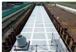
地下貯留施設整備（金沢市）
