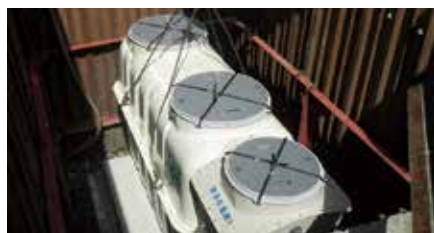
④合併浄化槽
