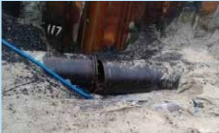
送水管の被害状況(令和6年能登半島地震)
