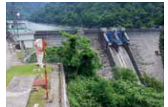
犀川ダム（金沢市） アクセス道路が脆弱な山奥に位置しており、 道路不通時は遠隔でゲート操作可能
