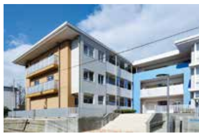
外断熱化（鶴ヶ丘県営住宅）
