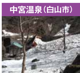
災害状況（平成24年2月22日）
