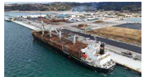
七尾港 大田岸壁 (-13m) 荷役の様子
