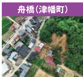
災害状況 家屋被災1戸 (令和5年7月13日)
