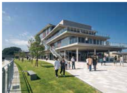
「羽咋市にぎわい交流拠点(LAKUNAはくい)」 (令和6年7月オープン) (羽咋市)
