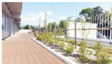
屋上緑化（金沢商業高等学校）
