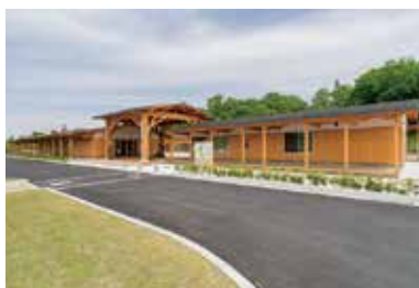
木場潟公園東園地里山交流ハウス
