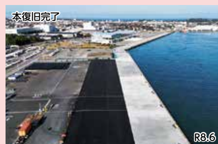
金沢港(金沢市戸水町)
