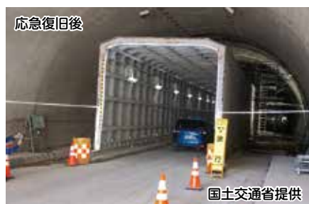
トンネルの応急復旧(国道249号 大谷トンネル工区)
