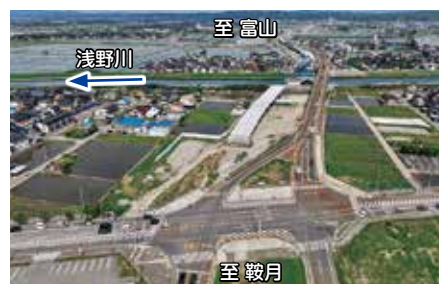
金沢外環状道路 海側幹線IV期 (令和4年11月 山側2車線暫定供用) (金沢市大河端町～福久町)
