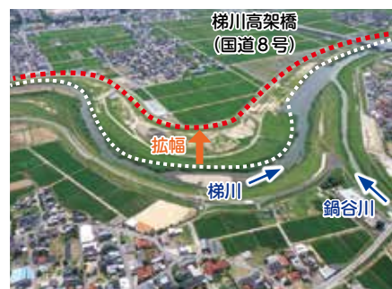
梯川（国道8号付近の拡幅）
