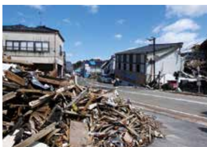
5 家屋倒壊(穴水町大町)
