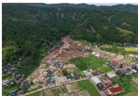
土砂災害(輪島市山本町)
