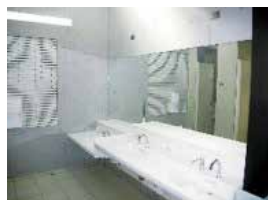
カウンター式洗面器の設置
