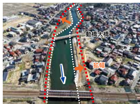
動橋川（動橋大橋付近の拡幅）
