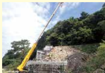
石材回収等の応急対策（本丸南石垣）
