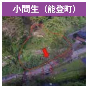
災害状況 県道破損 (平成29年10月23日)
