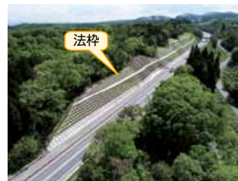
法面落石対策((主)七尾輪島線)
