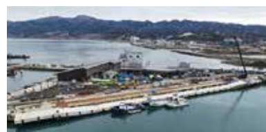
輪島港 災害復旧工事
