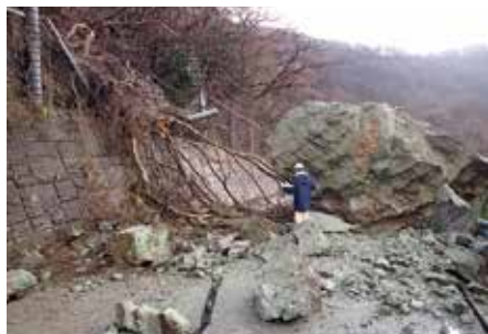
落石((主)大谷狼煙飯田線 珠洲市高屋町)
