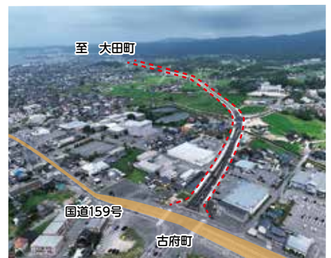
七尾外環状道路((都)外環状線) 令和8年7月供用
