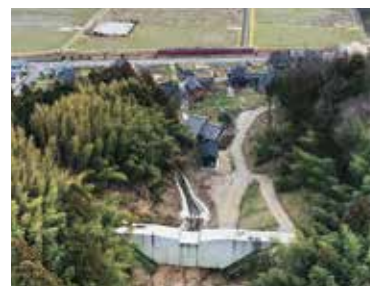
対策後の状況（平成31年3月）
