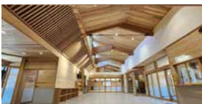
県産材が多数使用された構造材・仕上げ材
