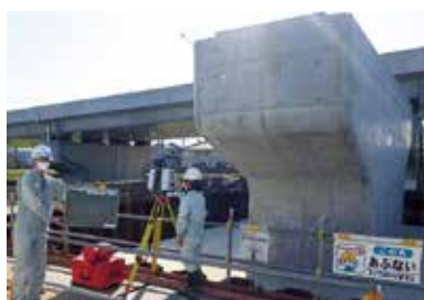
レーザースキャナーによる3次元測量
