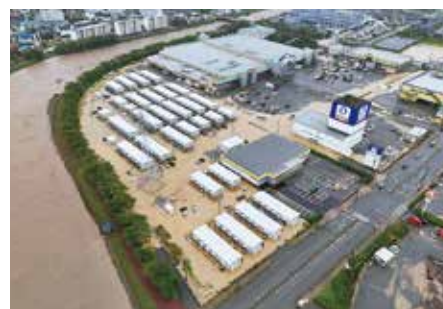
応急仮設住宅の浸水(輪島市宅田町)
