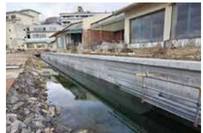
旅館横の護岸復旧状況（七尾海岸）
