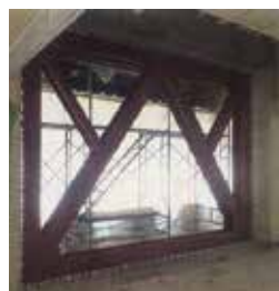
耐震ブレース設置中の様子
