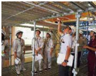
金沢城鼠多門工事現場
