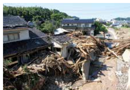
8 流木(輪島市久手川町)
