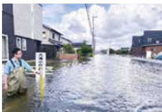
令和7年8月大雨の被災状況（金沢市）
