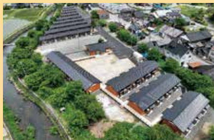
三井町第1団地(輪島市)
