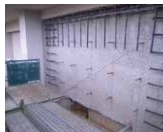
あと施工アンカー後の様子
