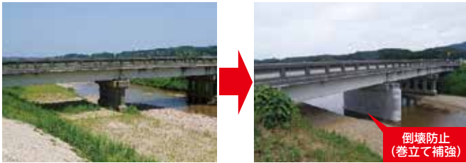
一般県道八野高松線 かほく市中沼地内（中沼橋）
