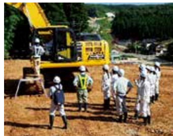
ICT建設機械の乗車体験
