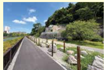
石垣復旧の見学ルート（R7整備）
