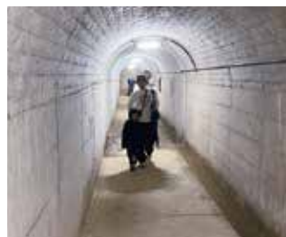
ダム監査廊の見学
