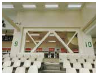
耐震ブレースの設置（金沢競馬場）
