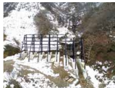
対策後の状況（平成30年2月）
