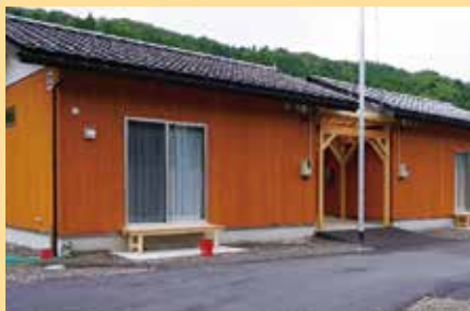
下唐川第2団地(穴水町)
