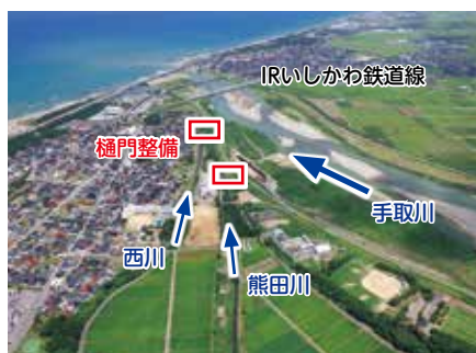
手取川（河口付近の樋門整備）
