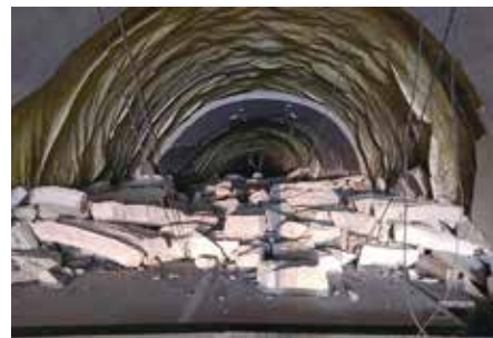
トンネルの損傷(国道249号 大谷トンネル)
