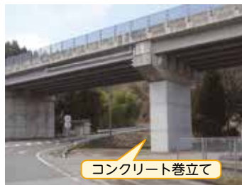
橋梁耐震補強(国道249号)
