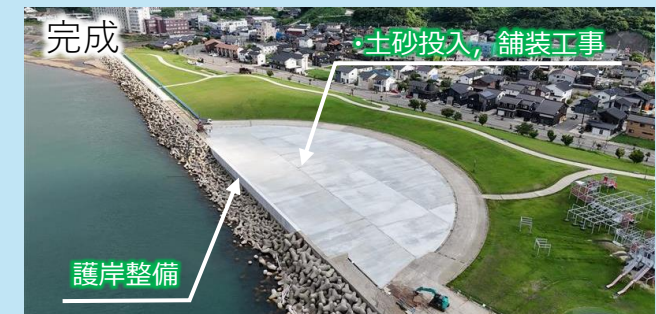
親水性護岸の平面化
