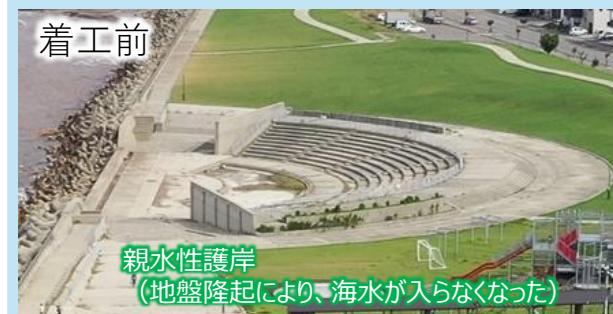
親水性護岸の平面化
