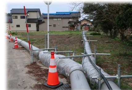
仮設水道管の設置 (珠洲市内)
