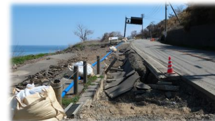
仮設水道管の設置 (輪島市内)
