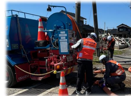
バキューム吸引 (珠洲市内)
