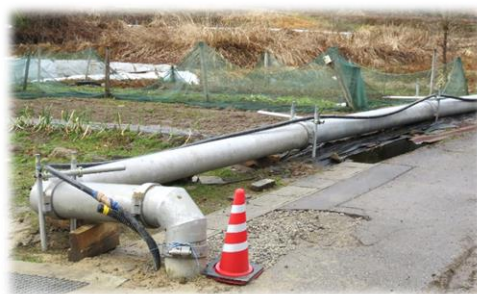
仮設水道管の設置 (珠州市内)
