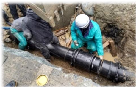
水道管の復旧作業 (輪島市内)
