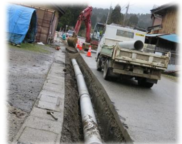
仮設の水道配管工事 (送水管の延長)
