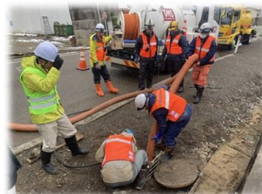
下水道管内の清掃
