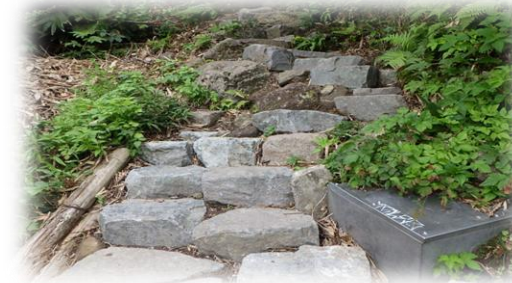
▲石段を整備し安全確保 (魅力ある登山環境の整備)
