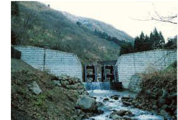
砂防堰堤（白山市）
