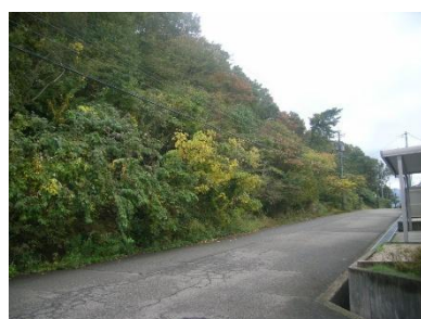
緩衝帯 整備前
