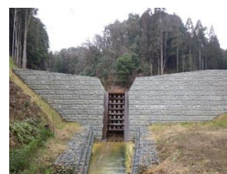
生態系に配慮した砂防堰堤
