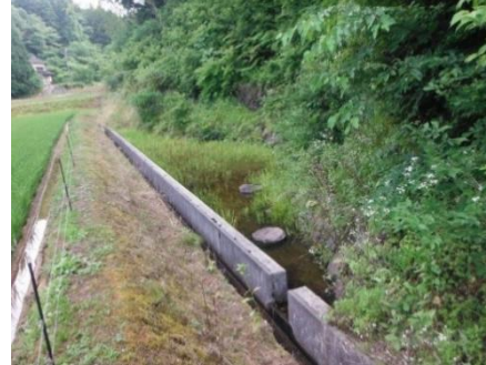
残地を利用したビオトープ
