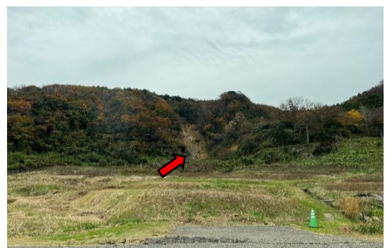
千枚田後背の森林の斜面崩壊（矢印）。地震後の傷跡が今も残っています。
