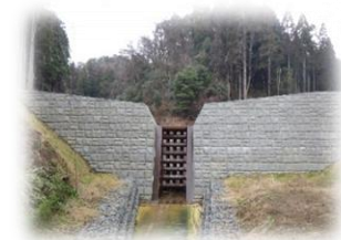
▲生態系に配慮した砂防堰堤
