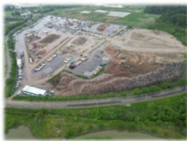
【仮置場】珠州市
