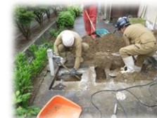
◀ 修繕工事の様子
