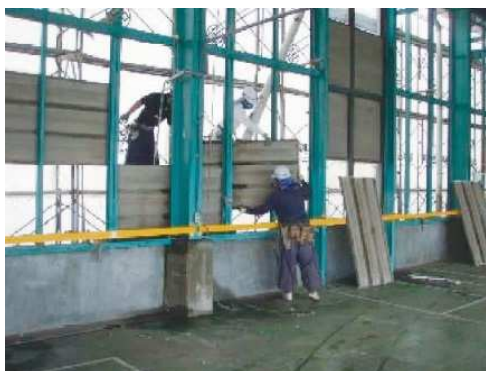
特定建築材料を切断、破碎等することなくそのまま建築物等から取り外す例
