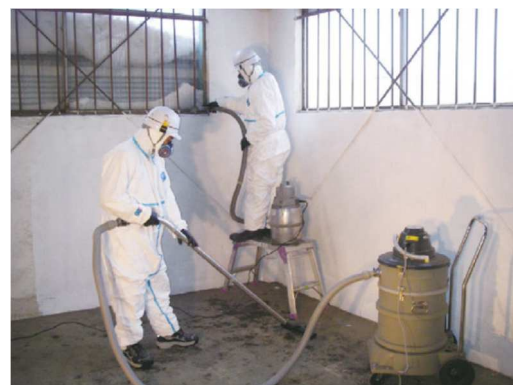
作業場内の仕上げ清掃の例 (高性能真空掃除機を使用)
