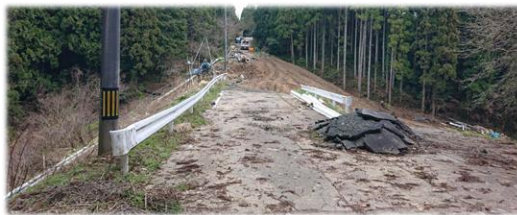
道路崩落箇所への仮設管の敷設
