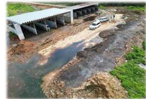
▲ 不適正処理現場（ドローン撮影）
