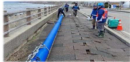
応急復旧活動（輪島市）
