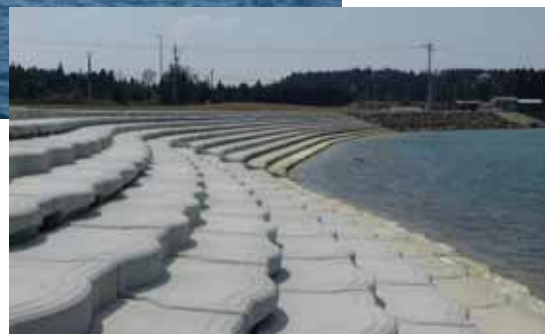
波をかたどった階段護岸
