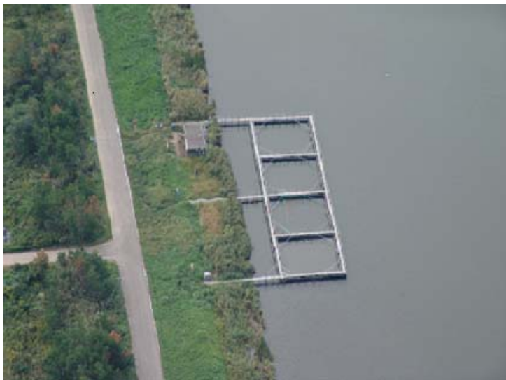
図3-2 西部承水路に設置された 隔離水塊
