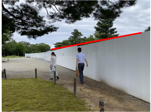
現在、工事のためにパネルが設置されている
