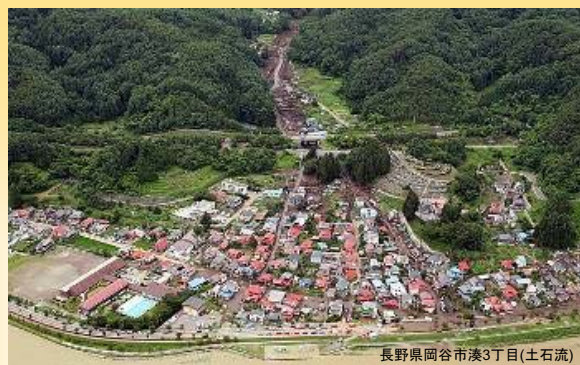
長野県岡谷市湊3丁目(土石流)
