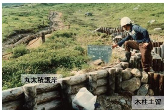
写真1 木柱土留めと丸太積護岸（施工当時）
