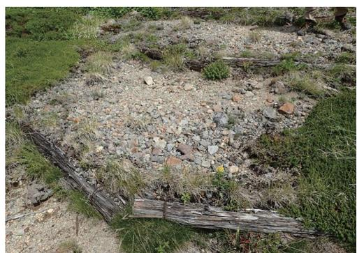
写真13 破損した丸太土留め
