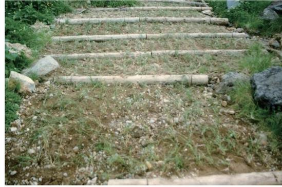
写真4 ヒロハノコメススキ移植と丸太土留め（施工当時）
