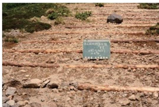
写真2 丸太土留め（施工当時）
