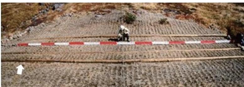
写真6 丸太土留めとヒロハノコメススキ移植（1990年施工当時）
