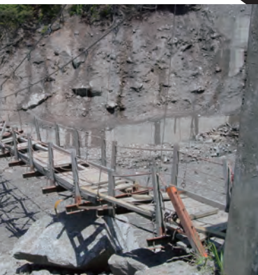
別当谷からの土石流で 破壊された別当出合の 吊橋（平成16年5月）
