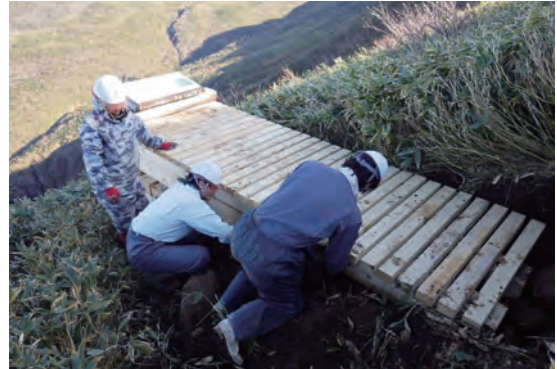
写真5 百四丈滝展望台の修繕
