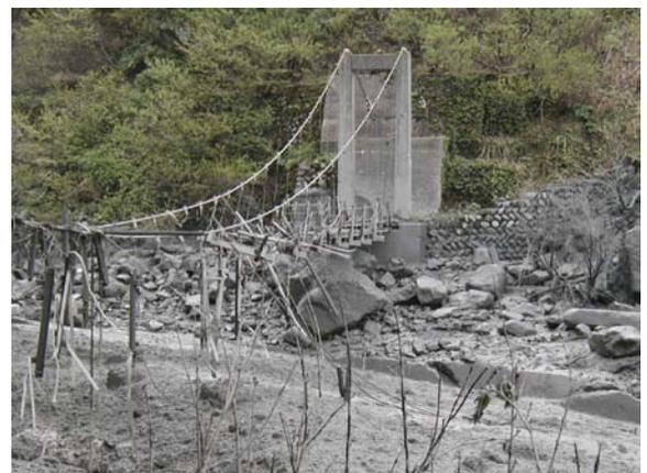
写真 1 土石流によって流された旧別当出合吊橋
