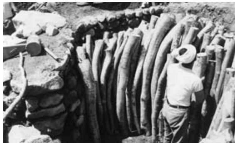
天井あげ1 木詰め
