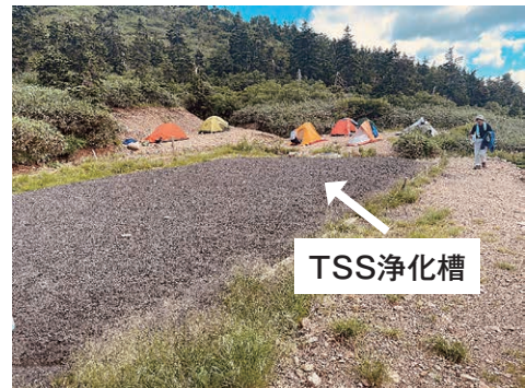
写真1 南竜野営場TSS浄化槽
