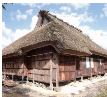
写真14 石川県内の茅葺屋根
