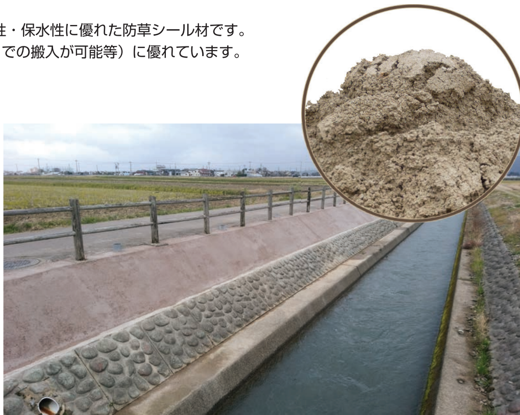
用水路法面／七ヶ用水 白山市剣崎町地内
