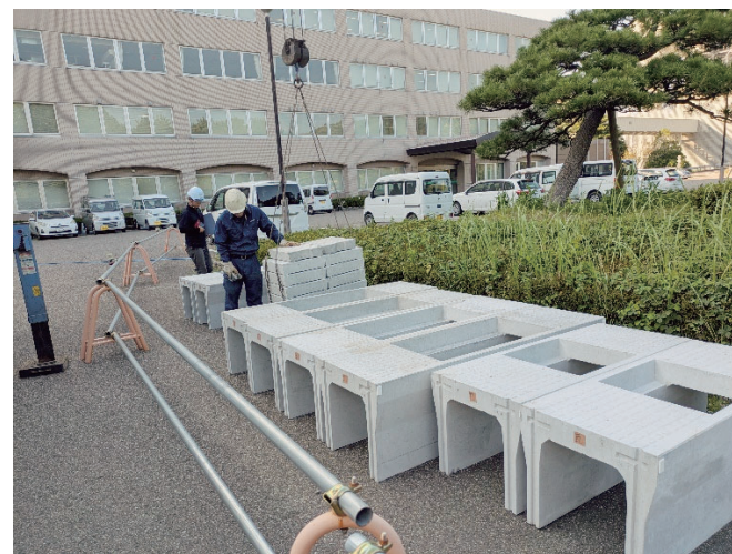
現場に納入された瓦入りコンクリート二次製品 (可変側溝)
