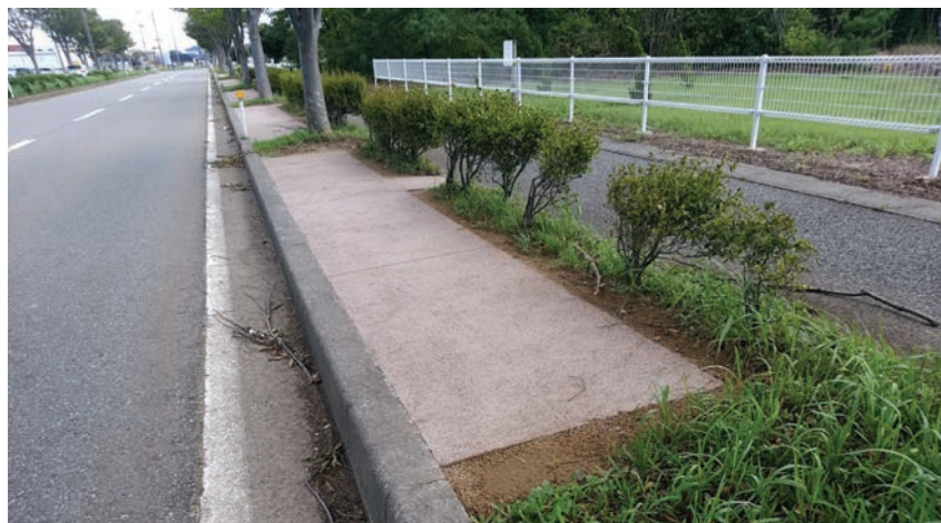
歩道植栽／国道360号 小松空港前
