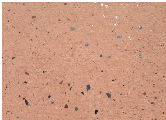
瓦コンクリ表面
