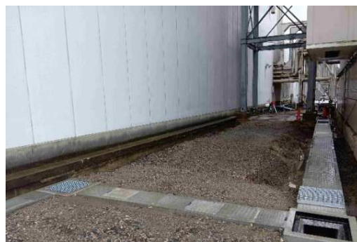
瓦入りコンクリート二次製品 施工現場
