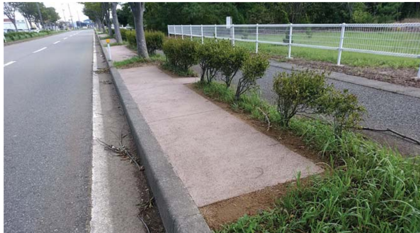
歩道植栽／国道360号 小松空港前
