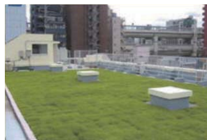
屋上緑化の基盤
