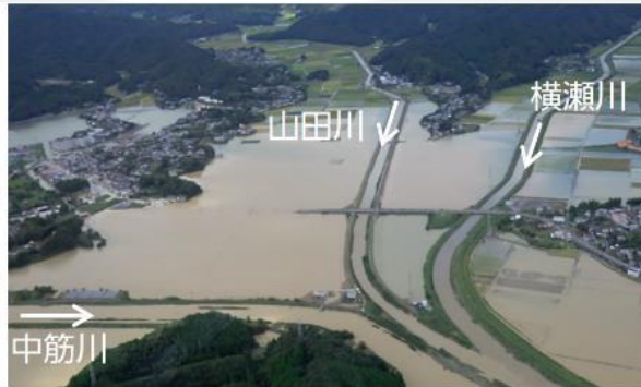
渡川水系中筋川・山田川・横瀬川 浸水状況（高知県宿毛市山奈付近）
