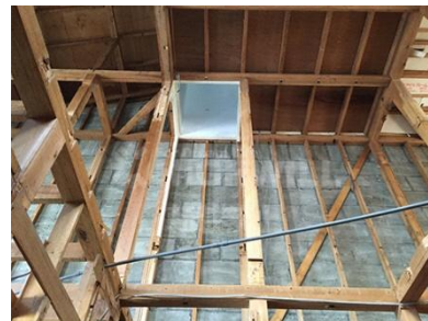
リフォーム工事現場
