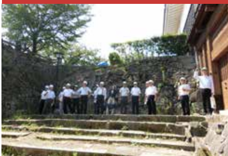
熊本地震に係る被害状況について調査（熊本城）
