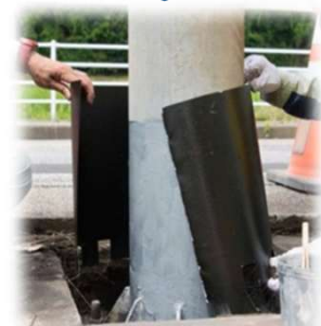
シート貼り付け
