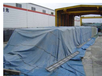
③養生状況
