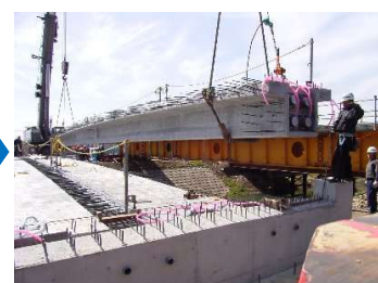
⑦主桁クレーン架設
