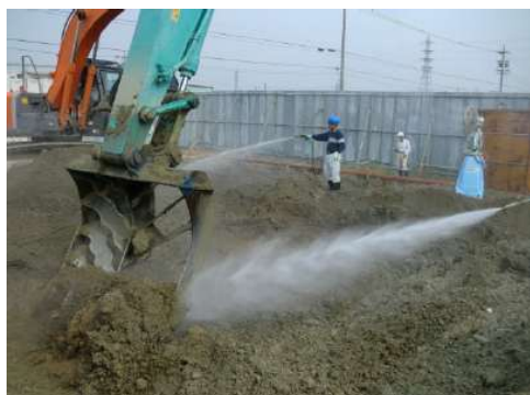
混合攪拌工法
