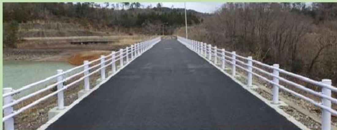
ダム堤体の復旧工事の完成
