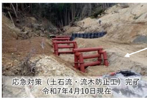
応急対策 (土石流捕捉工) 完了 令和7年4月22日現在
