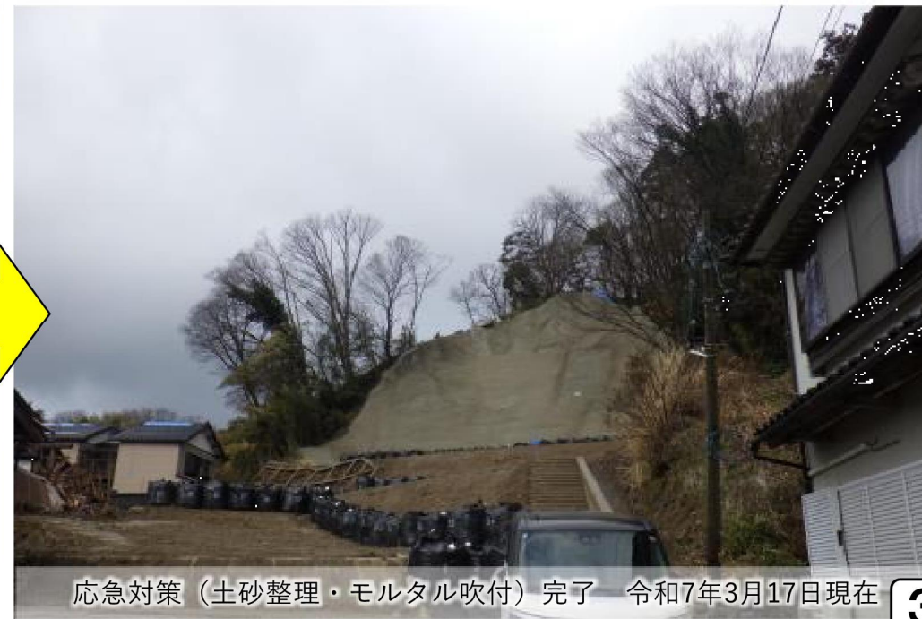
応急対策 (土砂整理・大型土のう設置) 完了 令和7年3月17日現在
