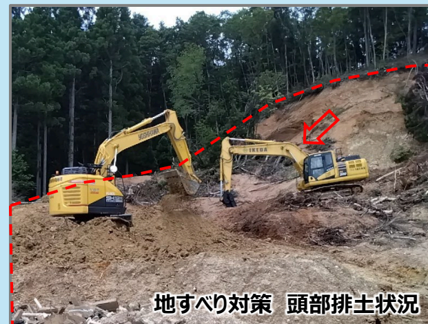
地すべり対策 頭部排土状況 ③原反坊（地すべり） (能登町字寺分地内)
