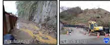
崩落土砂撤去状況 大型土のう設置状況
