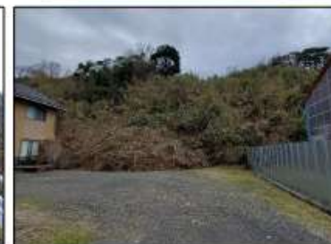
民家裏斜面崩壊
