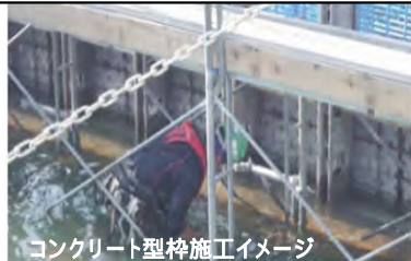
コンクリート型枠施工イメージ
