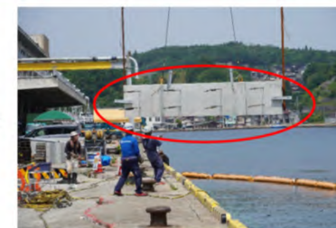
本體工(※残置型枠設置)
