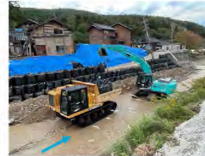
護岸の応急復旧作業状況
