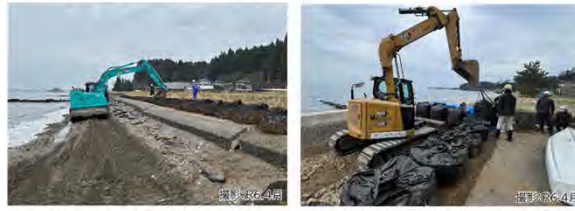
大型土のうによる応急復旧状況 【上戸地区】
