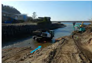
護岸の応急復旧状況
