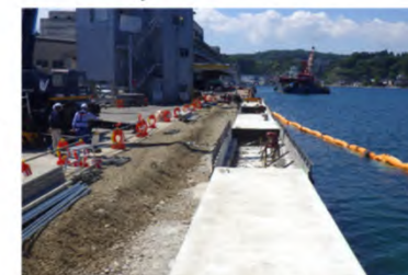
上部工(上部コンクリート打設)
