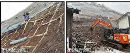
土砂流出防止工の施工状況 崩落土砂撤去の施工状況
