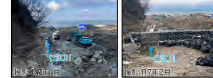
仮設護岸工の施工状況 土砂流出防止工の整備状況
