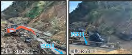
仮設護岸工の施工状況
