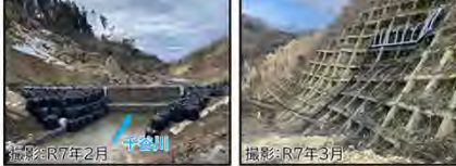
土砂流出防止工の整備状況 横ボラー工の整備状況
